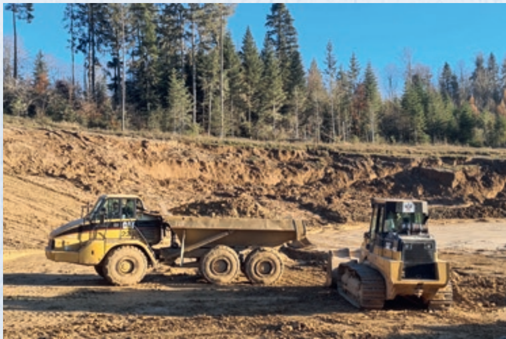
Le talus à l'arrière de l'image sera creusé pour étendre le potentiel de dépôts à la décharge.
